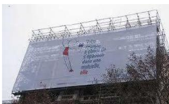
Publicité sur bâche de chantier
