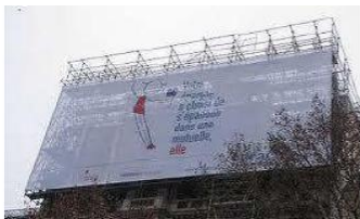
Publicité sur bâche de chantier
