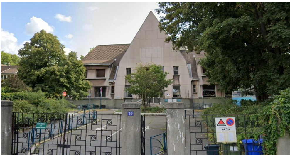
Groupe scolaire rue Mehul à Pantin.
